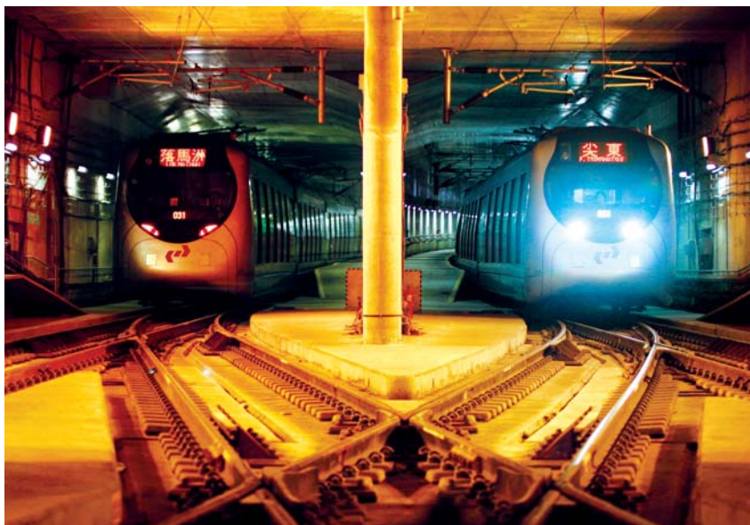
為免影響塱原一帶的環境生態，落馬洲支線大部分路段均建於隧道內。
